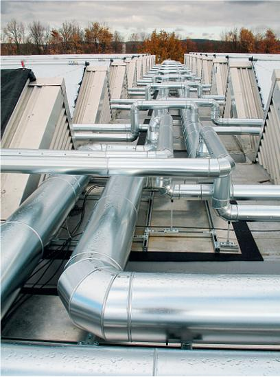
Abb. 3.3-6: Blick auf die Verrohrung im Kollektorfeld
