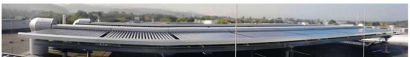
Abb. 3.2-5: Vakuümrohrluftkollektorfeld der STAR1-Pilotanlage in Freiburg. Kollektoren des Typs Sun-Storm der Kollektorfabrik GmbH & Co. KG. Die Kollektoren sind horizontal (0°) auf dem Dach ausgerichtet. Die außenliegenden Luftkanäle sind isoliert
