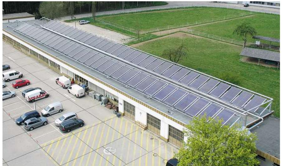
Abb. 3.1-1: Kollektorfeld der solaren Klimatisierungsanlage Rottweil
