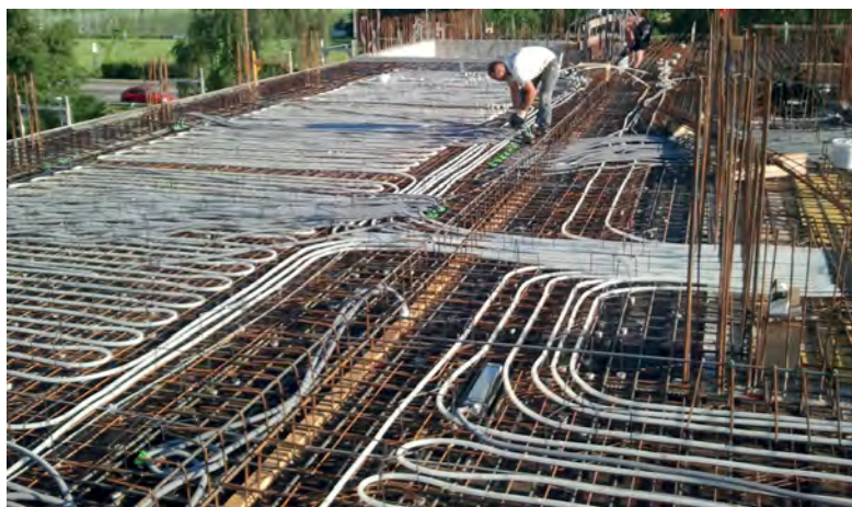
Abb. 1: Verlegung der Heizrohre für die thermische Bauteilaktivierung des Passivseminarhauses Gebäude E der HAW Offenburg. Diese Rohre ermöglichen es, die massiven Decken des Seminargebäudes mit Grundwasser zu kühlen oder mit Abwärme der Energiezentrale der HAW zu beheizen (Quelle: Prof. Dr.-Ing. Jens Pfafferott)
