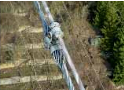
Eine Klemme an einer Hochspannungsleitung, die zu Inspektionszwecken angeflo-gen wurde
